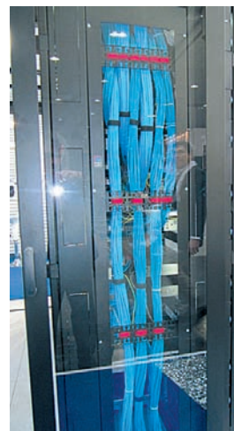
Рис.1. Пример монтажа кабелей Cat. 6A и Cat. 6
